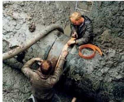
Inspección de soldaduras de petróleo y gas utilizando película
