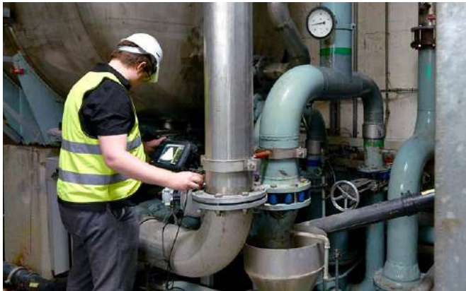
Inspección de tubería industrial con Proceq Flaw Detector 100
